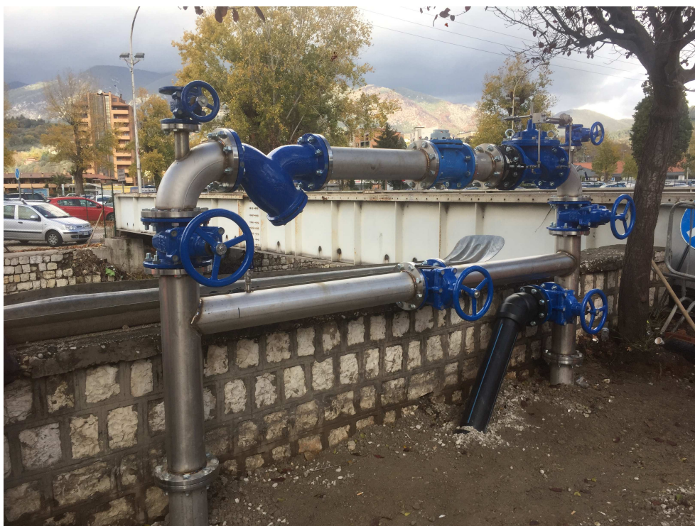
Figura 6.5 Cameretta di controllo e regolazione via BREDA Terni
