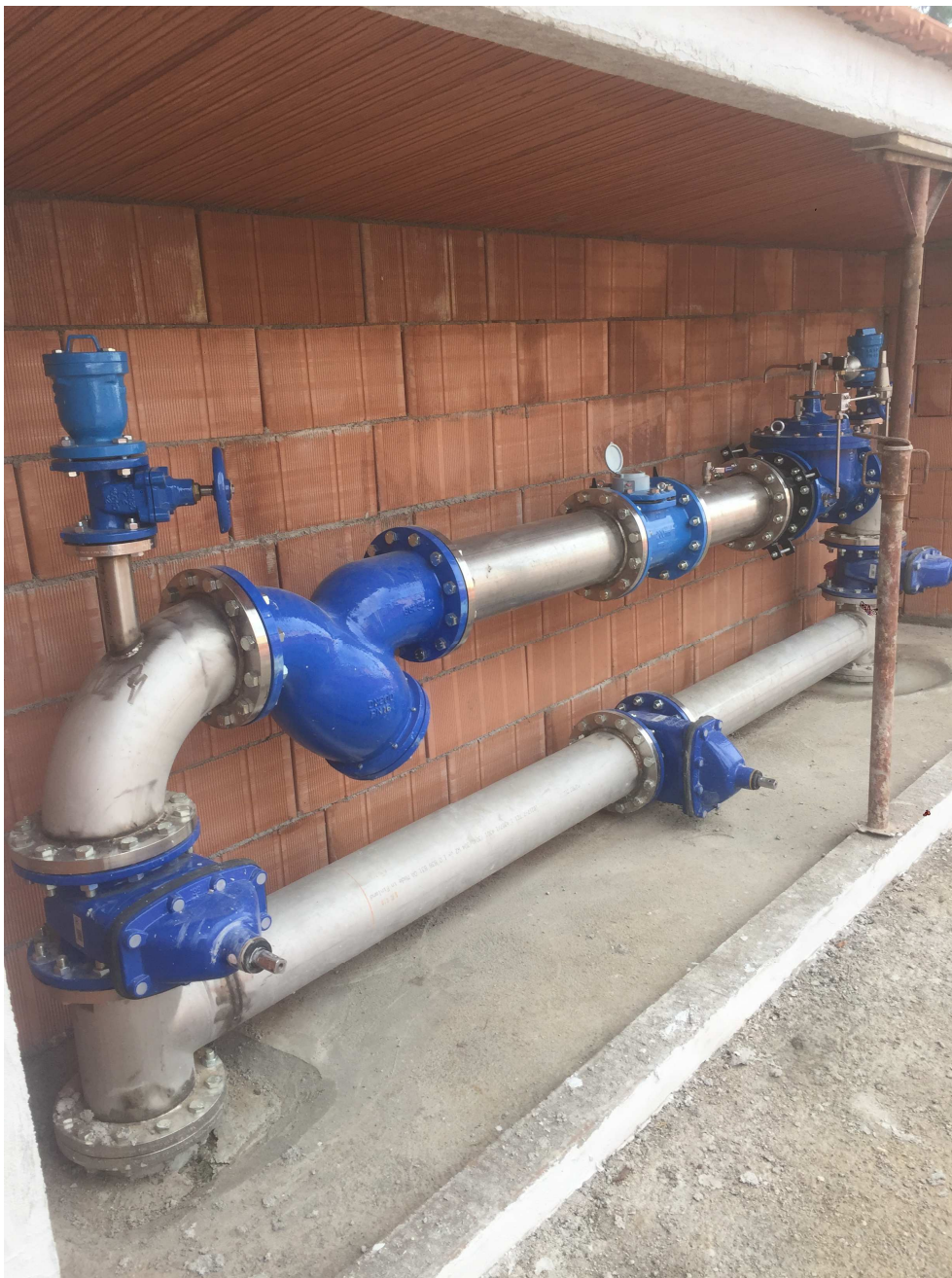
Figura 6.4: Valvola riduttrice di pressione del distretto via Ippocrate a Terni
