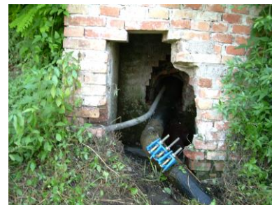
Foto 1.2 – Condotte in uscita per Narni Scalo via Tre ponti
